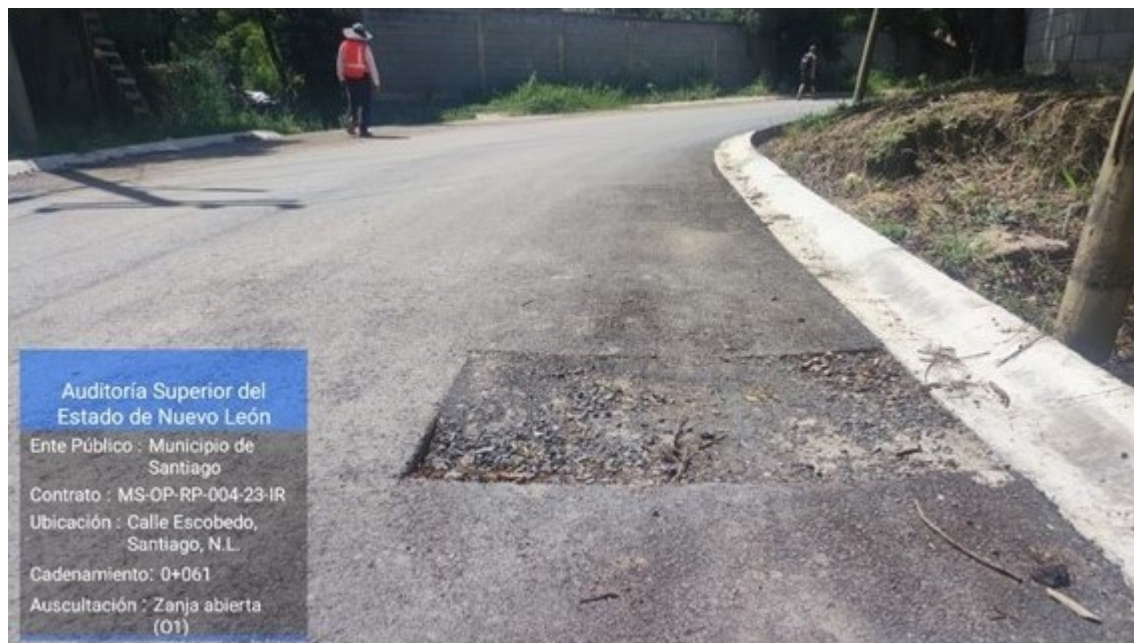
Zanja abierta, ubicada en el cadenamiento 0+061 de la calle Escobedo.
